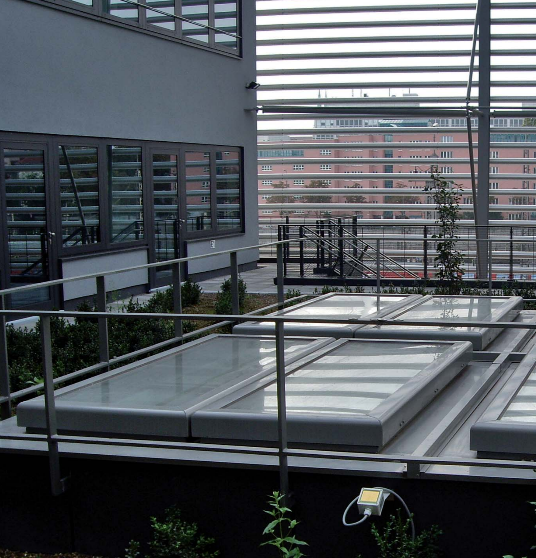
Großes Bild: FIREFIGHTER DUO als NRW für ein Erdgeschoss
